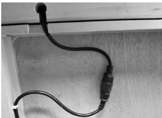
(1) Conectați mufele cablurilor de încălzire, Asigură-te că cablurile nu sunt bine conectate
