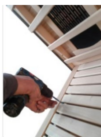
(9) Postavite klop in jo pritrdite z vijaki 4x50 mm
